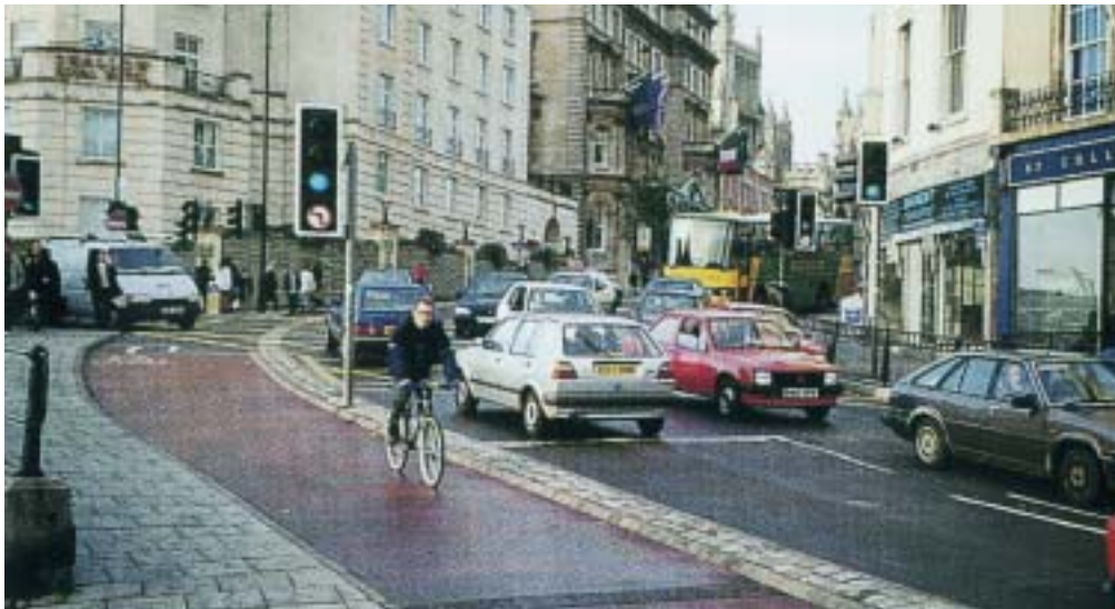
Φωτ. 5.5. Αποκλειστικός διάδρομος διαχωρισμένος από το οδόστρωμα με συνεχή λιθόστρωτη λεπτή νησίδα
