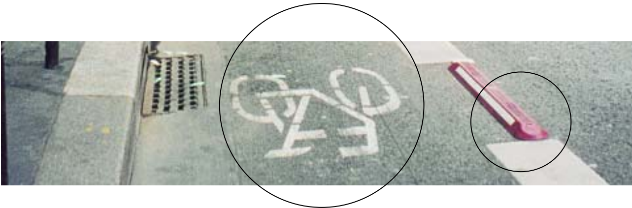
Φωτ. 5.1. Paris. Γαλλία. Bd Saint Michel. Λωρίδα ποδηλάτου που οριοθετείται με πλαστικά στοιχεία.
