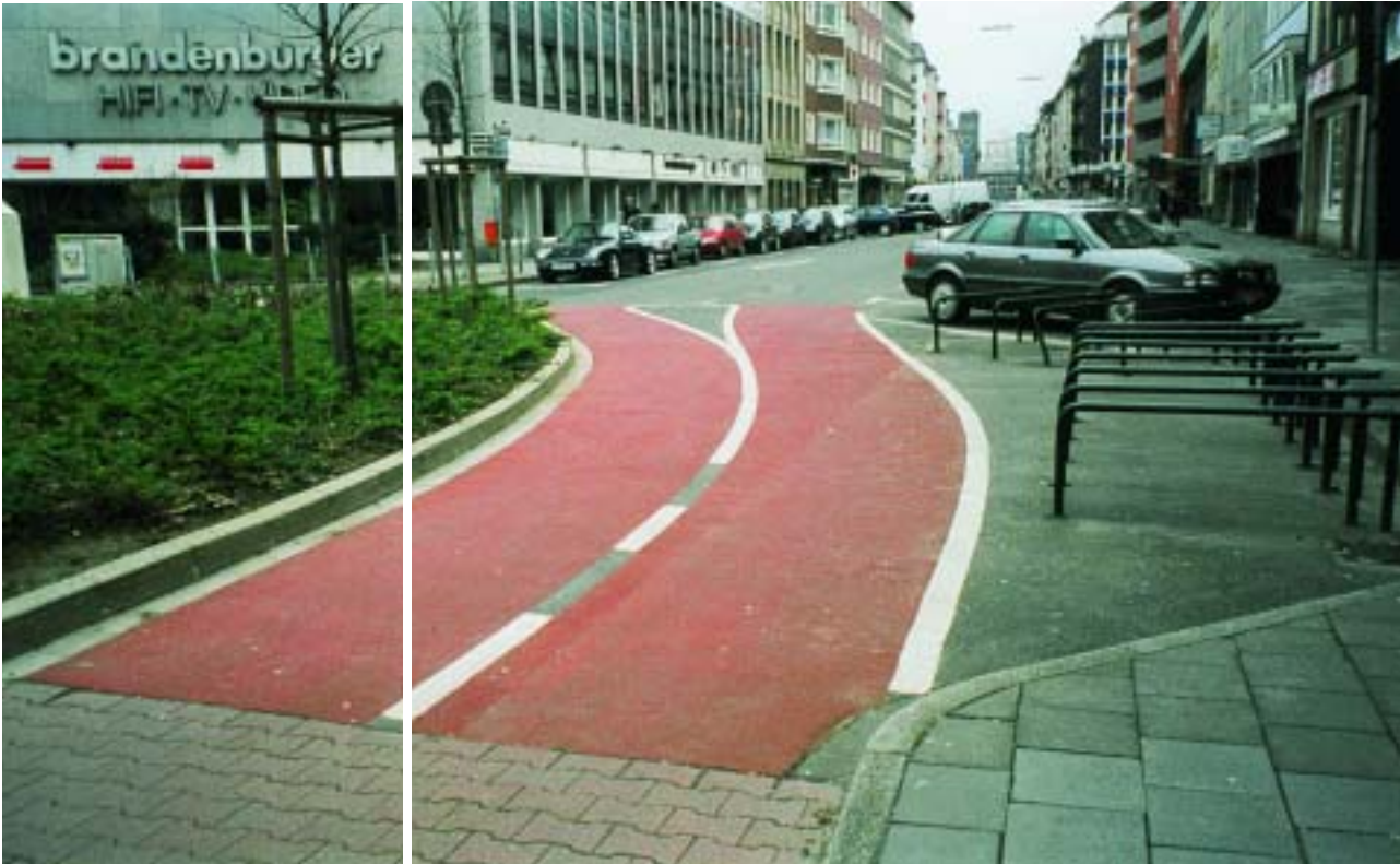
Φωτ. 5.4. Dusseldorf, Γερμανία. Τμήμα αμφίδρομου ποδηλατόδρομου με κόκκινο χρώμα. Διακρίνονται δεξιά, μεταλλικά σπρίγματα για τη στάθμευση των ποδηλάτων.
